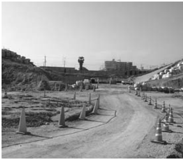
工事が進む大江霊仙寺線
