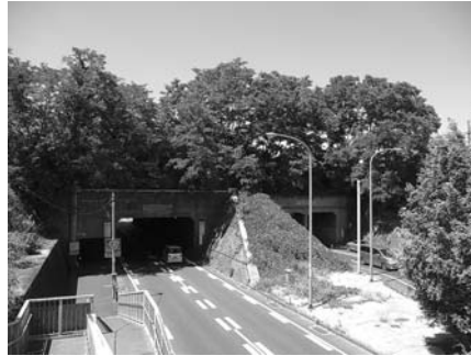
撤去される予定の国道1号草津川トンネル
