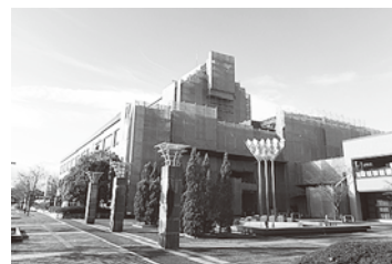
長寿命化のため外壁改修工事の進む市役所庁舎
